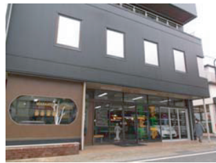
サイディングボードを施した外壁。つや消しの黒でモダンな外観を演出。
